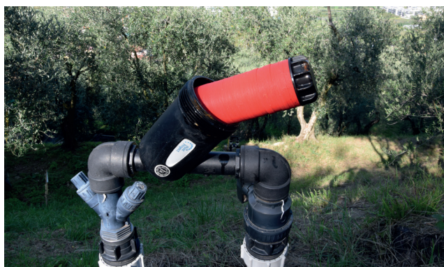
4) Rimontare il disco, evitando di tirare eccessivamente la vite, e inserire il filtro nella cartuccia
